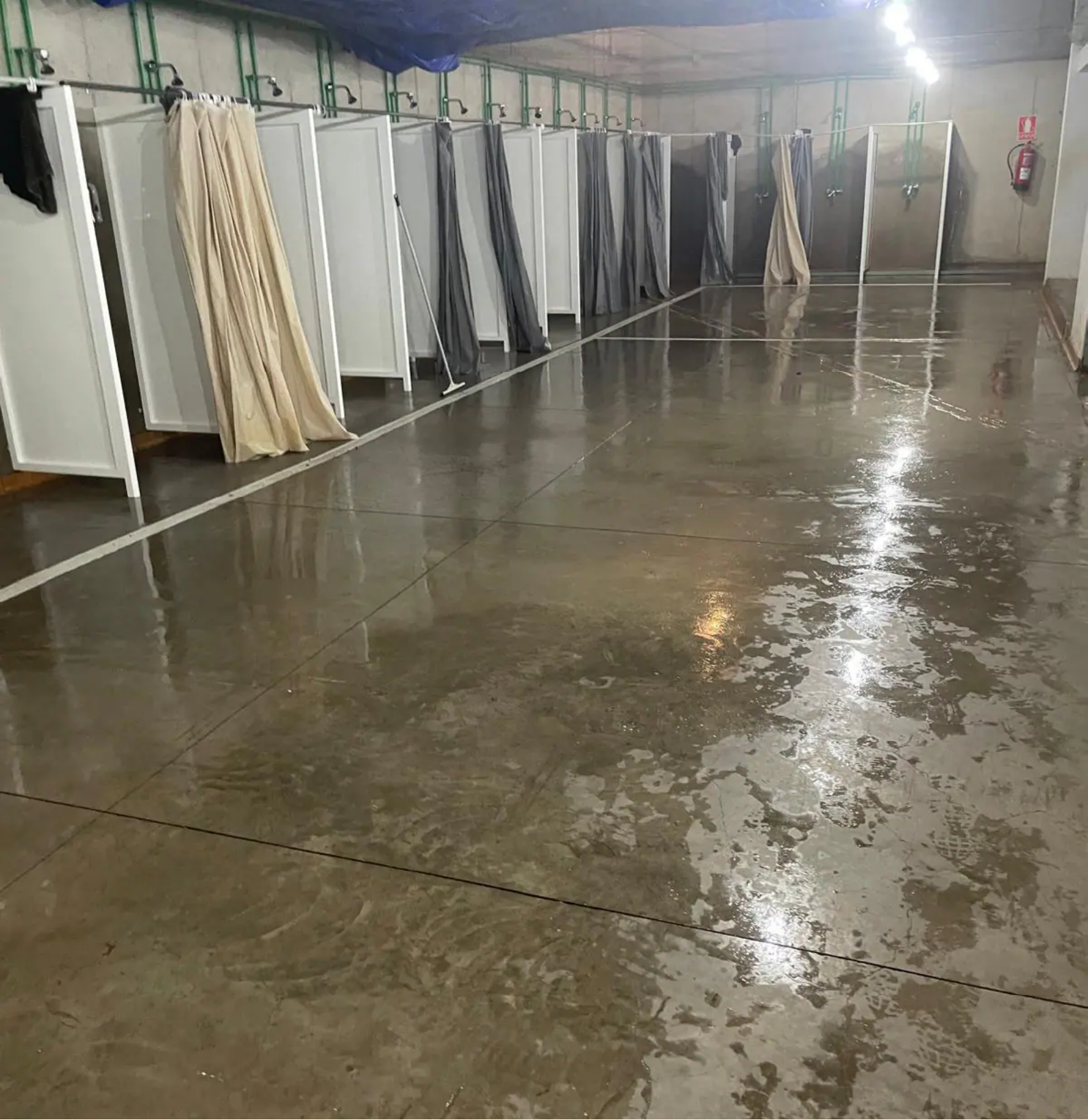
Interior del centro de menores de Hoya Fría, duchas. Fotografía de Cadena Ser. 109
