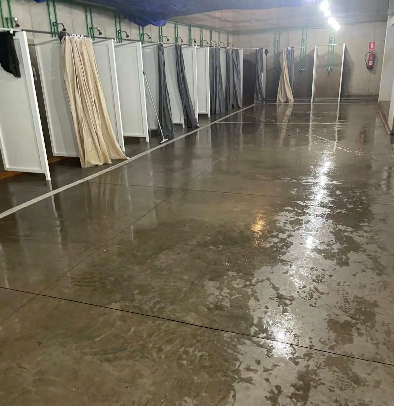
Interior del centre de menors d'Hoya Fría. Dutexes. Fotografia de Cadena SER. 109
