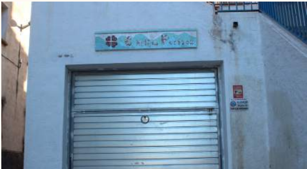
Local de Càritas Portbou, habilitat en un aparcament als voltants de la parròquia (2025)
