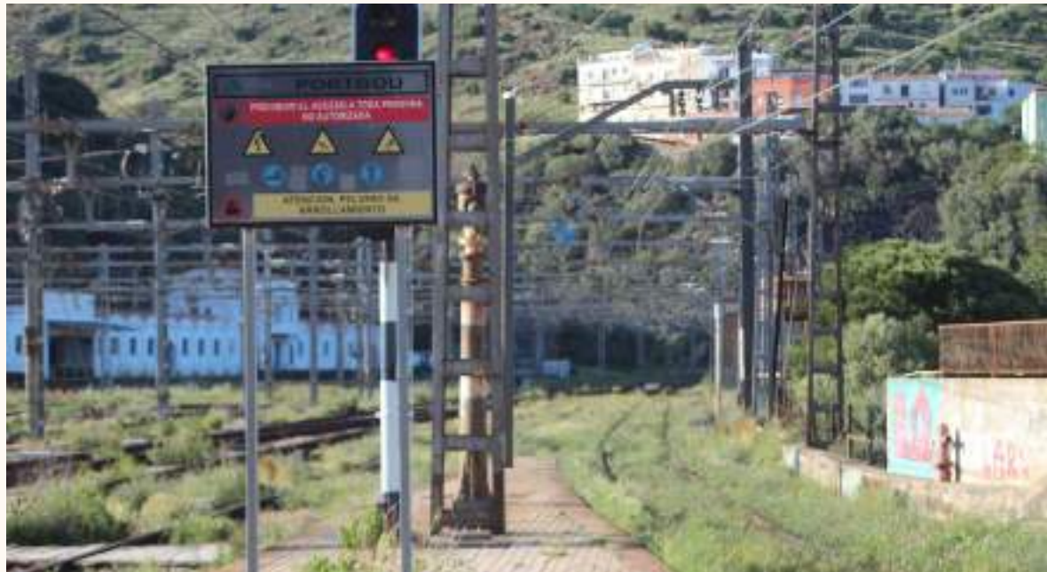
Senyalització de perillositat als voltants del túnel ferroviari dels Belitres (2025)
